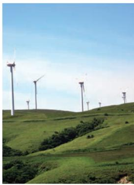
日本最北端の宗谷丘陵の約1500haの牧草地にある風力発電所。出力1000kwの風力発電機が57基設置され、稚内市の年間消費電力の約7割に相当する電力を発電している。
