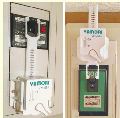
レバー式 震度 5+・6- (設定) で作動
